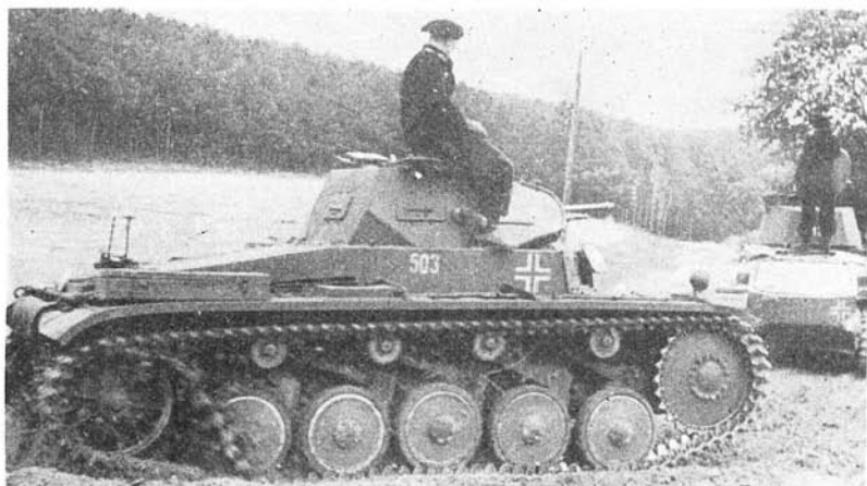
Figure 90.— Pz. Kw. II (Sd. Kfz. 121) . Light tank.
